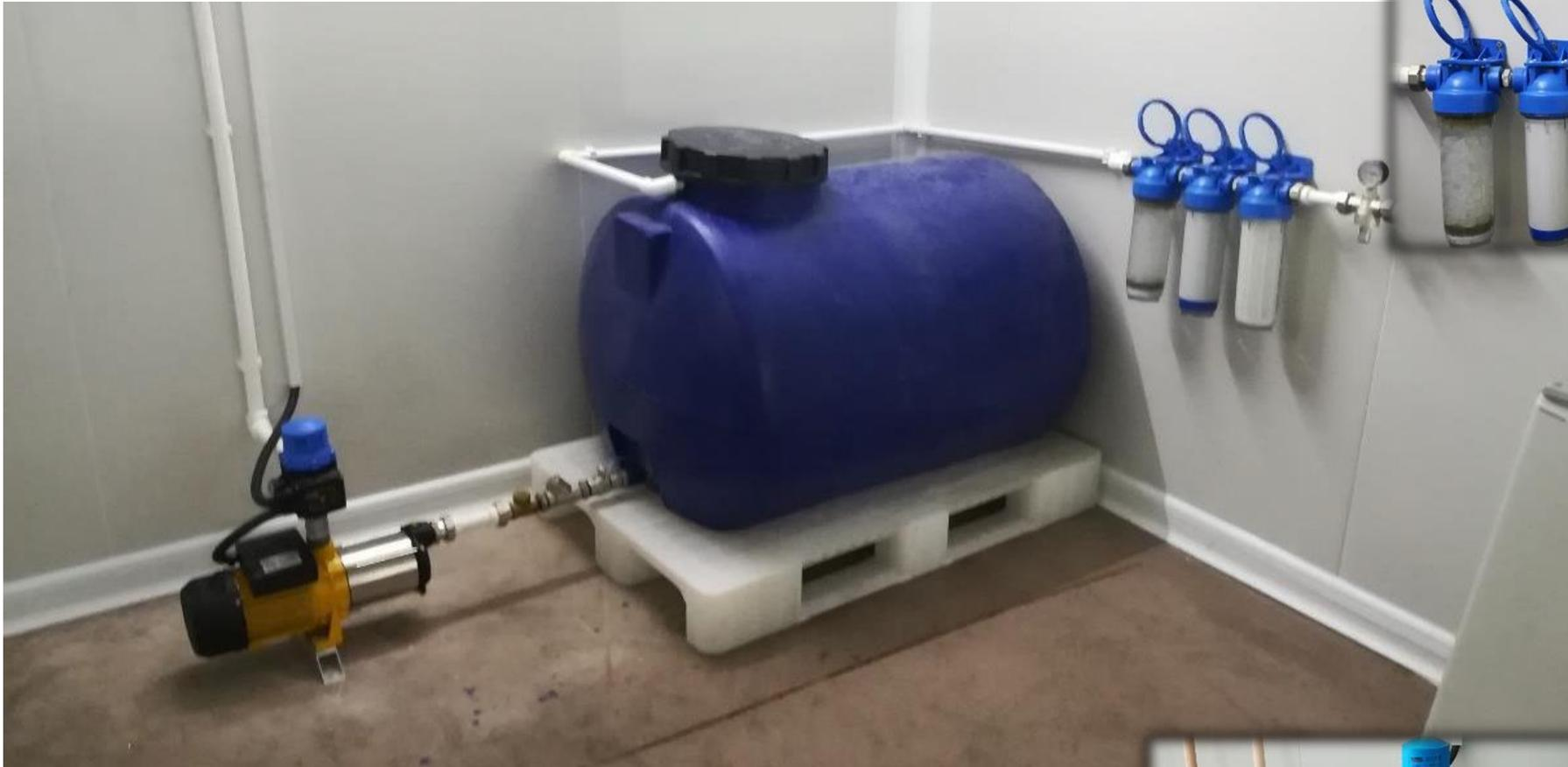
Система орошения с резервуаром для предварительной подготовки и фильтрами.
